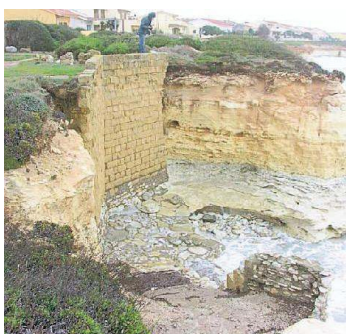
S'Anea Scoada: un vecchio muro di contenimento minacciato dal mare. Su Pallosu: erosione della spiaggia
